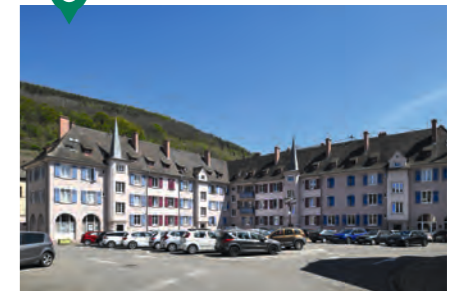
#Ravalement de façade | Guebwiller Place du Marché – 26 logements
