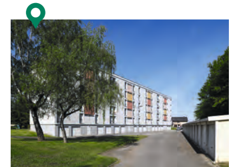
#Ravalement de façade | Huningue Rue Schuman – 80 logements
